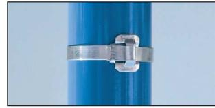
Mit dem Hammer das Band auf die Schlaufenbrücke schlagen und zur Sicherung des Bandendes die beiden Ohren der Schleife umlegen.
