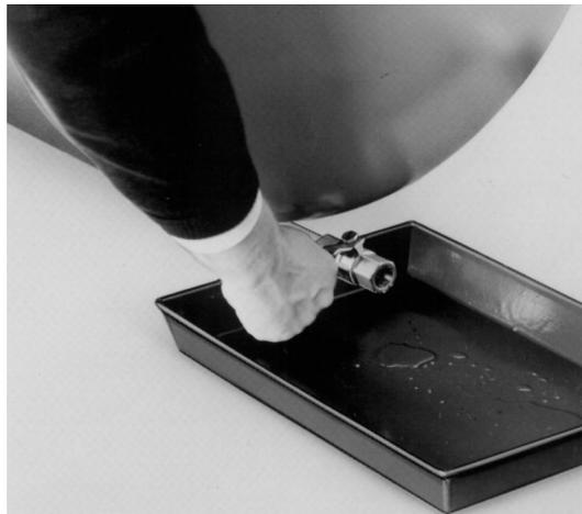
Abb. 2.12: Kondensat manuell ablassen
