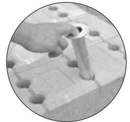
Die obersten äußeren Bauzaunfüsse sind mittels Bauzaunfußsicherung, Art.-Nr. 29343 gegen Herausfallen zu sichern.
