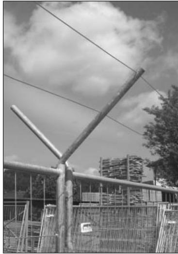
Um das Übersteigen der Bauzäune zu verhindern wird ein Übersteigschutz Art.-Nr. 29440 auf den Bauzaun montiert.
