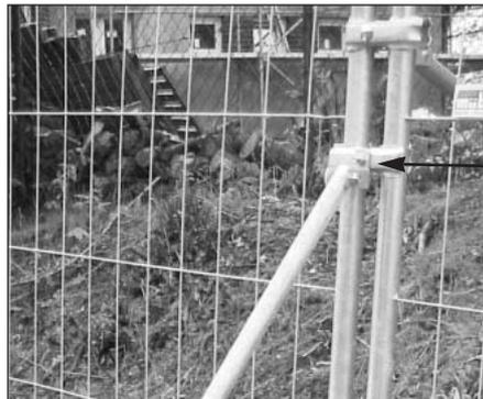
Besonders in schwierigem Gelände läßt sich die Bauzaunabstützung flexibel einsetzen. Die Bauzaunabstützung wird mit dem Befestigungssatz verschraubt. Die Höhenverstellung erfolgt durch Verschieben des Befestigungssatzes (nur Art.-Nr. 29340).
