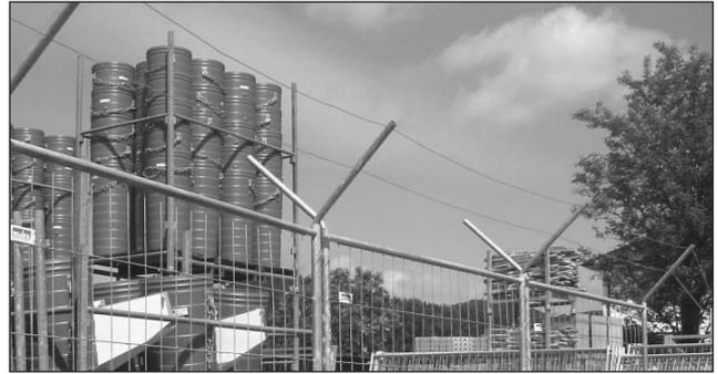
Der Mobilzaunständer Art.-Nr. 29270 in Kombination mit dem Erdnagel Art.-Nr. 29260 oder dem Erdnagel mit Sicherungshaken Art.-Nr. 29220 ergibt auch im Gelände eine sichere Aufstellung des Bauzaun- Systems
