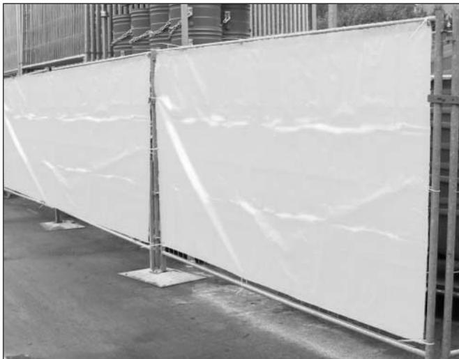
Zum Sichtschutz der Baustelle bieten wir desweiteren Sichtschutzplanen bzw.- Netze an, welche durch Kabelbinder Art.-Nr. 61079 schnell mit dem Bauzaun verbunden werden können.
