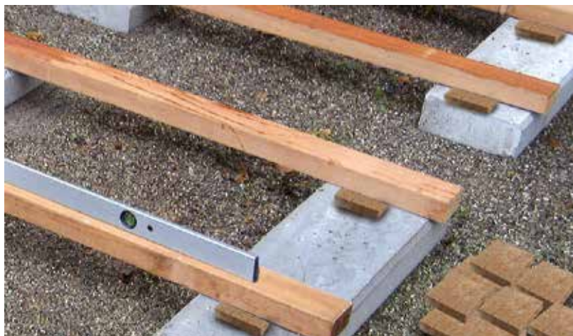
Almohadilla distanciadora de corcho instalada en una subestructura de terraza.
