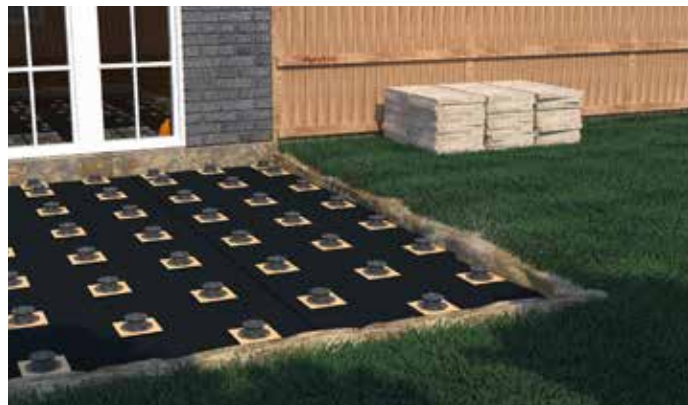
Подготовка основания с регулируемыми опорами Profi-Line
