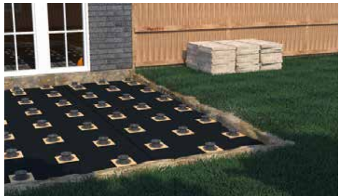
Forberedelse af en underkonstruktion med justerbare fødder fra Profi-Line
