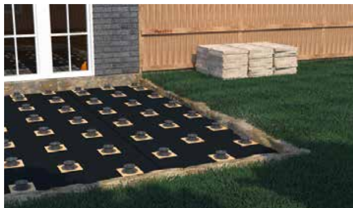
Przygotowanie podkonstrukcji ze stopami przestawnymi PRO
