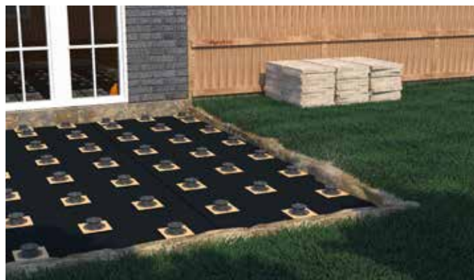
Przygotowanie podkonstrukcji ze stopami przestawnymi PRO
