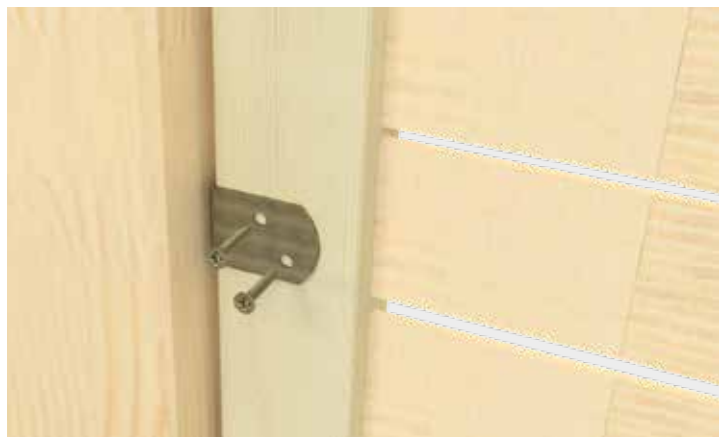
Późniejszy montaż poszczególnych elementów płotu
