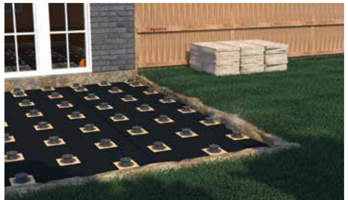
Preparazione di una sottostruttura con piedi regolabili Profi-Line
