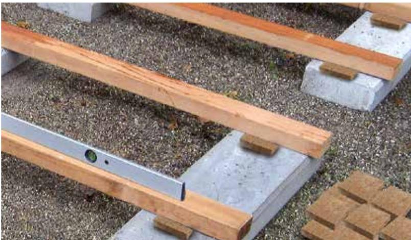
Il distanziatore Kork-Pad si monta nella sottostruttura di un terrazzo.
