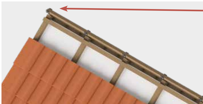
Montaggio del supporto per listello di colmo e displuvio 50 su falsi puntoni
