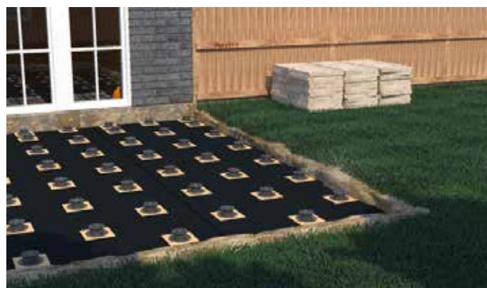
Preparazione di una sottostruttura con piedi regolabili Profi-Line
