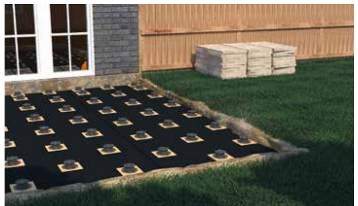
Préparation d'un soubassement avec pieds de réglage Profi-Line
