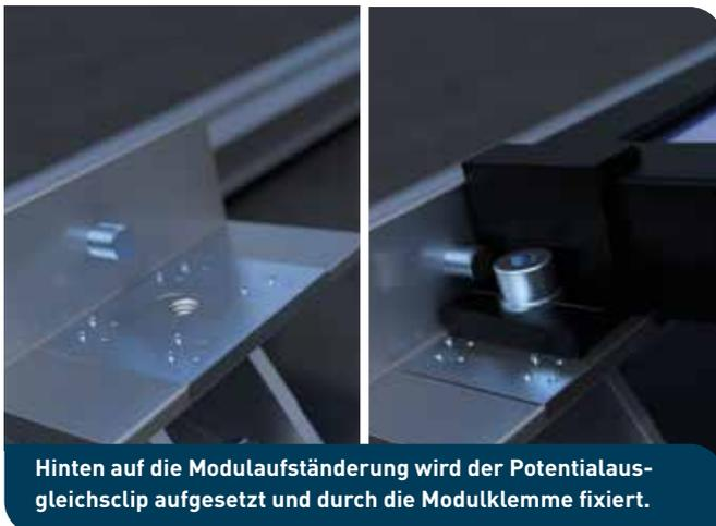
Hinten auf die Modulaufständerung wird der Potentialausgleichsclip aufgesetzt und durch die Modulklemme fixiert.
