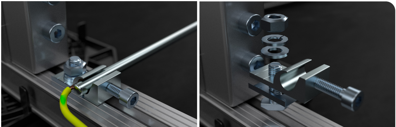
Befestigung des Erdungskabels mithilfe der Erdungsklemme an dem Montageprofil.
