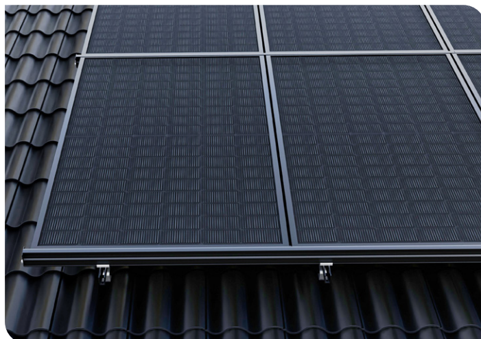
SCHRITT 19: Nachdem alle Solarmodule eingesetzt und die Endkappen montiert sind, ist das Einlegesystem vollständig aufgebaut.
