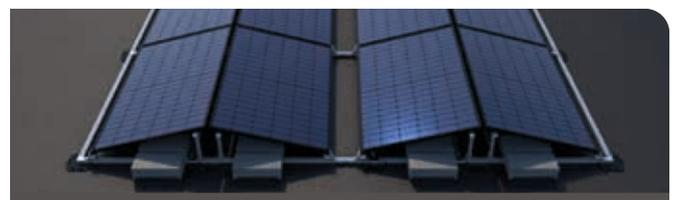
**Schritt 4:** Beginnend bei der ersten Modulfeldreihe, können Sie nun die Solarmodule auf die Modulaufständerungen setzen und mit Modulklemmen fixieren.
