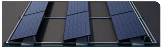
**Schritt 4:** Beginnend bei der ersten Modulfeldreihe, können Sie nun die Solarmodule auf die Modulaufständerungen setzen und mit Modulklemmen fixieren.
