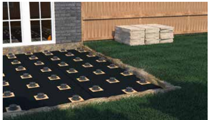
Vorbereitung einer Unterkonstruktion mit Profi-Line Verstellfüßen
