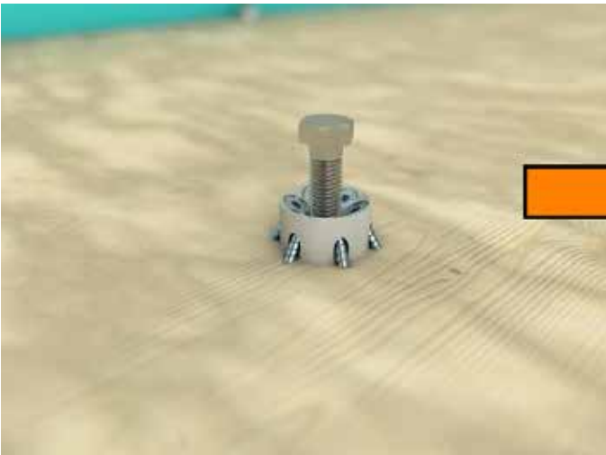
Schritt 5: Bringen Sie eine 200-Mikron (0,2 mm) dicke Polyethylenfolie auf dem Holzbauteil an mit Öffnungen für jeden TCC MAX. Die Löcher müssen gerade so groß sein, dass ein TCC MAX durchgehen kann (ca. 45 mm).
