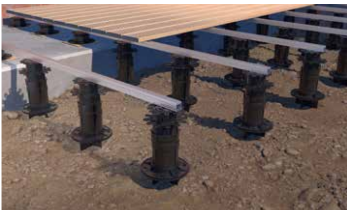
Erweiterung eines Terrassenfundaments mit dem Erdanker FLEXI.
